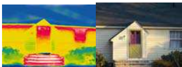
Budynek: Strata ciepła
