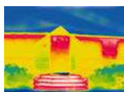
Budynek: Strata ciepła
